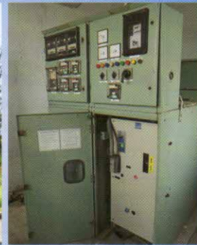
MV Switchgear
